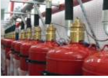
Gazlı Söndürme Sistemleri
